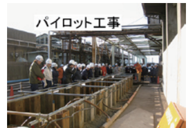
パイロット工事
