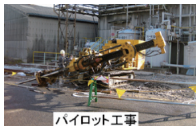
パイロット工事
