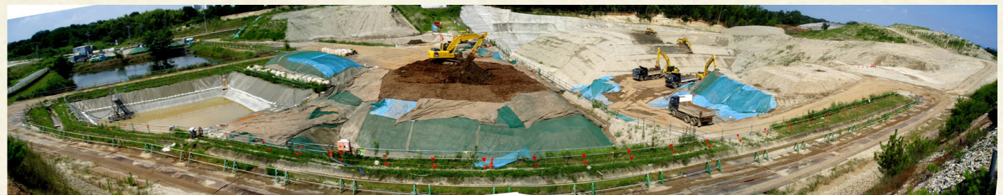
2010年7月 幡中地区工事写真
