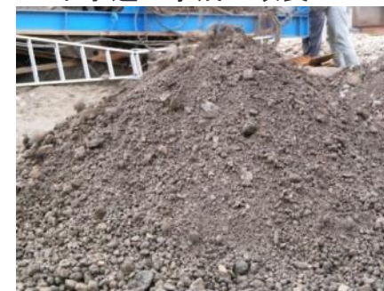
下水道工事残土改良
