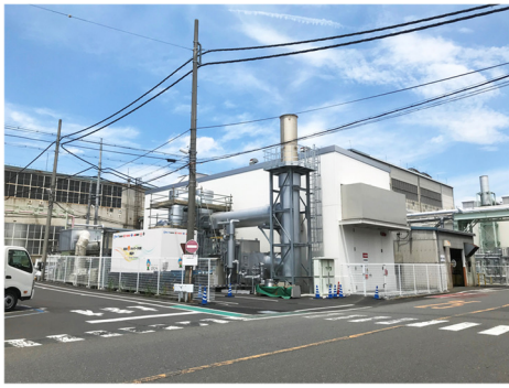
図3 蓄熱サイト外観 (日野自動車(株)羽村工場内のCGS)
