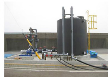
バリア井戸揚水中継タンク
