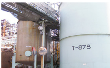
バリア井戸揚水処理設備
