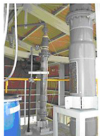
宙水浄化設備
