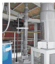
宙水浄化設備
