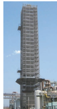
塩素法煙突耐震化工事
