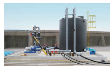
バリア井戸揚水中継タンク
