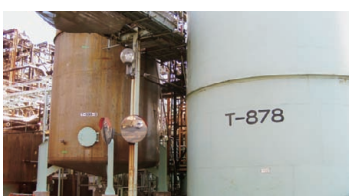
バリア井戸揚水処理設備
