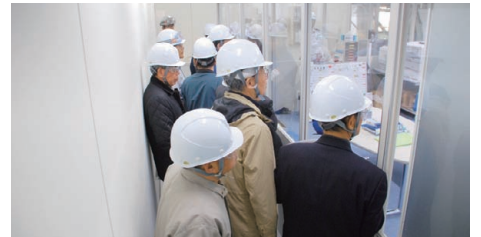
新規制御装置を導入した計器室
