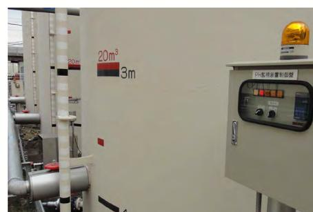
pH 異常遮断装置 (貯留タンクに設置した pH 計)
