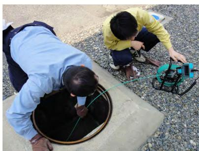
カメラ付きファイバーによる排水管内部の点検
