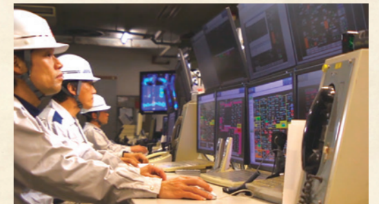
安全・安心な操業を支える計器室
