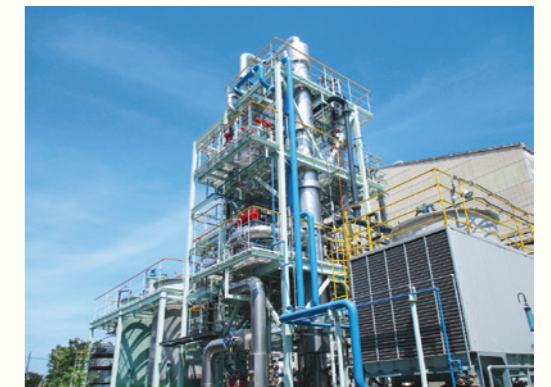
排水中のアンモニア低減を目的としたアンモニーストリッピング設備
