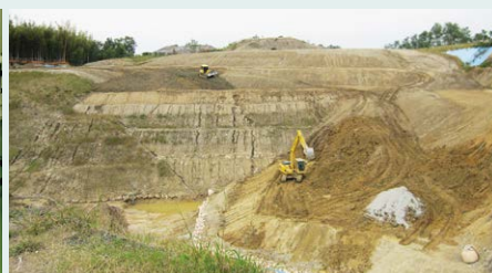
フェロシルト回収工事の様子
