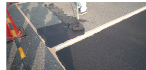
黒色遮熱塗料施工風景
