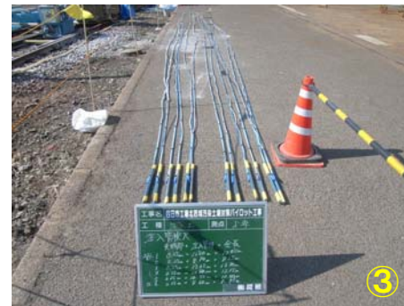
恒久グラウト材の注入配置図
