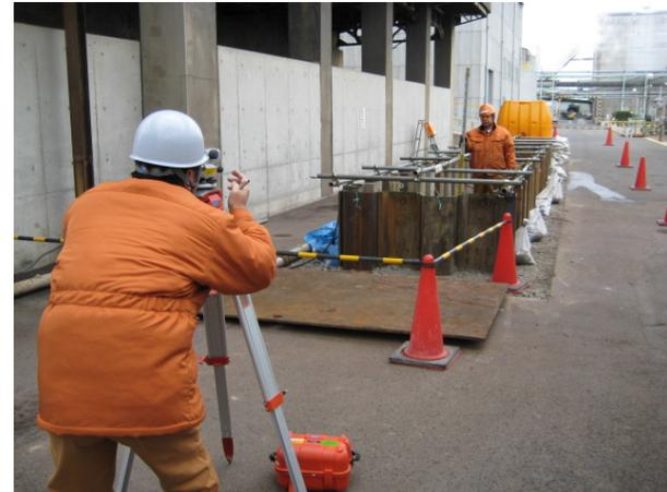
揚水時の沈下測定 (沈下なし)
